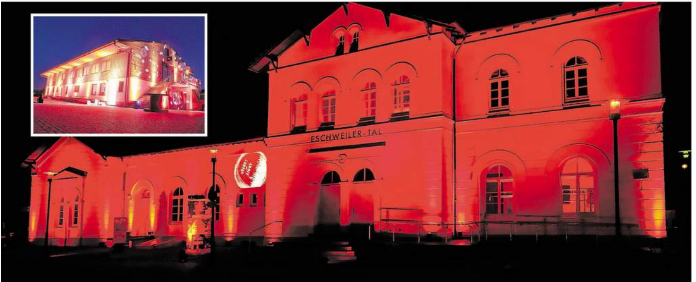
In ganz Deutschland wurden Stätten der Kultur rot illuminiert, um ein „Mahnmal“ für die darbenende Veranstaltungswirtschaft zu setzen. Auch der Talbahnhof und das Vereinsheim des SV Breinig (kleines Bild) erstrahlten in einem tiefen Rot.
